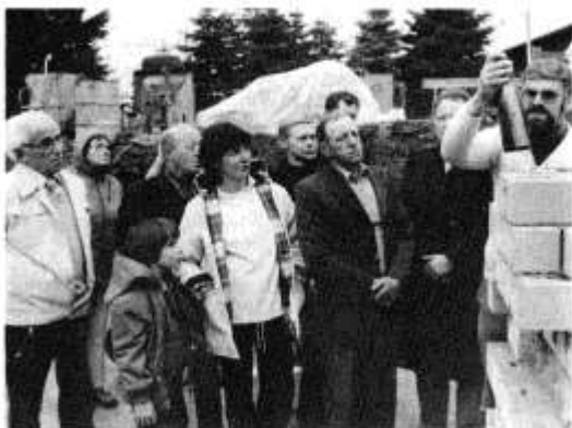
Grundsteinlegung des neuen Pfarrhauses 1982
